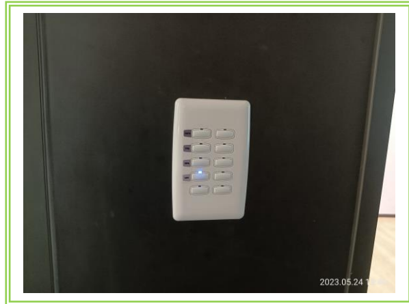
รูปที่ 3-39 เครื่องปรับระดับแสงสว่าง พร้อมจอแสดงผลจุดติดตั้งแสงสว่าง
