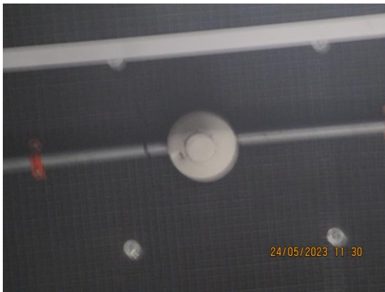
รูปที่ 3-33 เครื่องตรวจจับควัน (Smoke Detector) ภายในห้องเครื่องหม้อแปลงไฟฟ้าโครงการ
