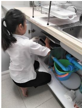
รูปที่ 3-13 เจ้าหน้าที่ที่ดักไขมันออกจากบ่อดักไขมัน
