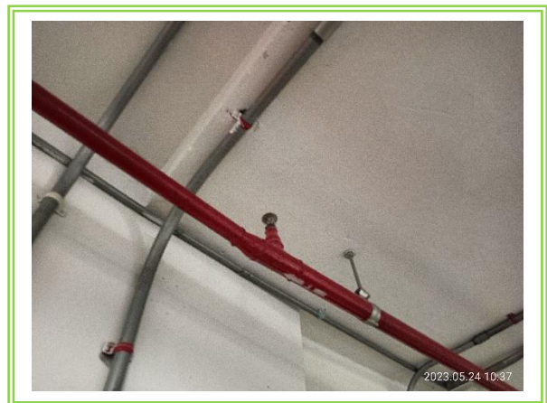
รูปที่ 3-45 หัวกระจายน้ำดับเพลิงอัตโนมัติ (Sprinkler System)
